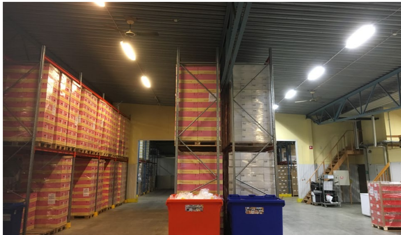
Ny belysning i lagerlokal. Energieffektivisering, minskad elförbrukning med minst 50%, minskad värmeutveckling samt bättre belysning vid byte från konventionella lysrör till led belysning.
