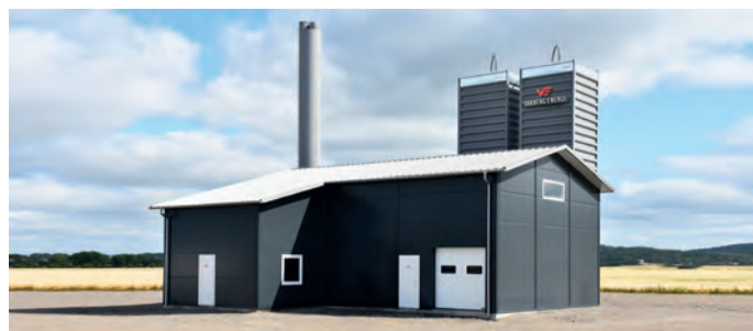
En panncentral i Tvååker möjliggör att fler kan ansluta sig till fjärrvärme.
